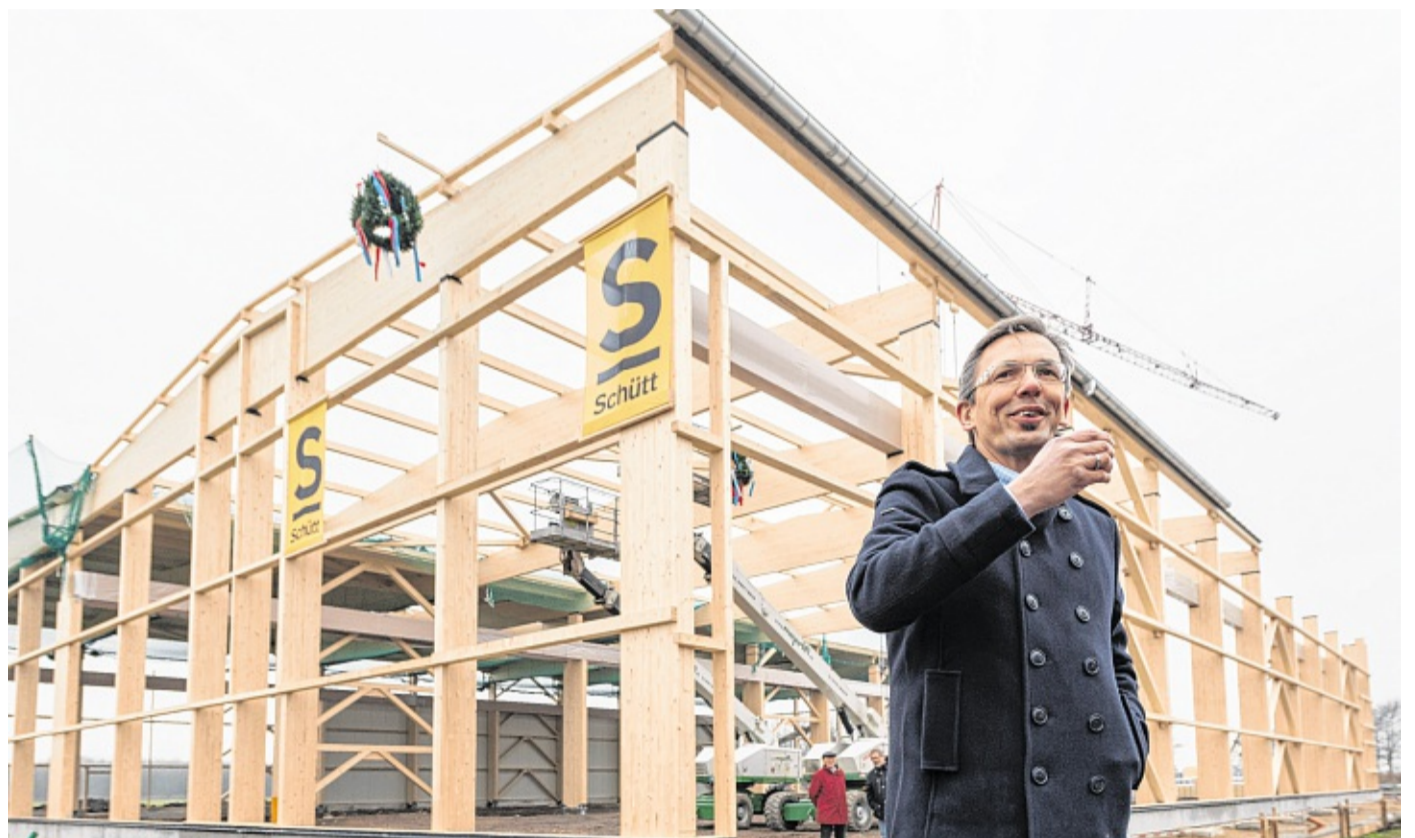
Stößt auf rosige Zeiten mit dem Baustoff Holz an: Tillmann Schütt beim Richtfest der neuen Fertigungshalle. RUFF
